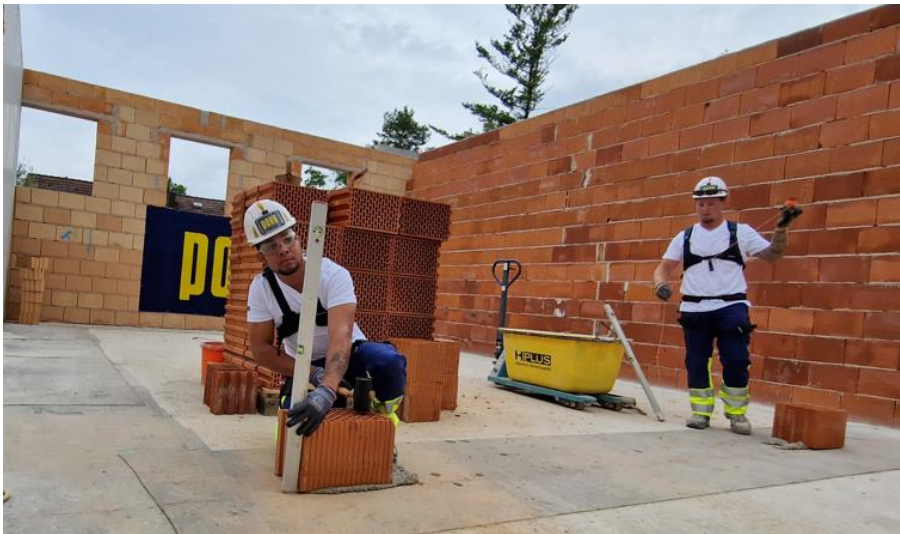
Exoskelette unterstützen auf der Pilotbaustelle beim Heben von Ziegelsteinen © PORR
